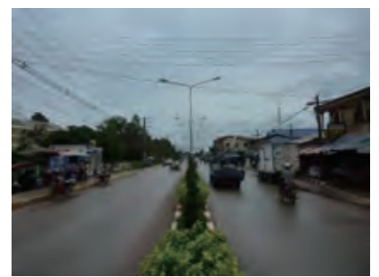
【Savang Rd】 中央分離帯を持つ4車線の道路であり、バスベイとバスシェルターを持つバス停がある。
