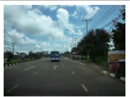
【Higway13】 中央分離帯のある6車線の幹線道路であり、信号や左折帯も整備されている。
