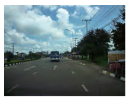
【Higway13】 中央分離帯のある6車線の幹線道路であり、信号や左折帯も整備されている。
