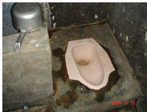
写真6. 屋内のトイレ
