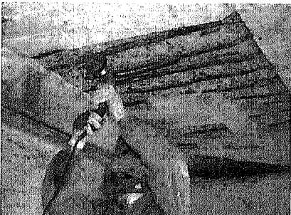
๑) สกัดคอนกรีต สกัดผิวบริเวณที่จะทำการซ่อมแซมเป็นพื้นที่กว้างๆ ด้วยเครื่องขัดกระดาษทราย (Disk sander)
