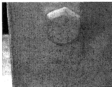
ภาพ 3.5.4 : Bolt ที่รับแรงสูง (F10T)
