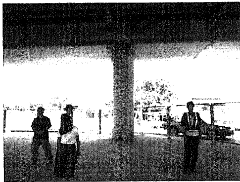
ภาพ 3.3.7: การลาดเอียงของเสาตอม่อของสะพานพระราม 5 (ฝั่งธนบุรี)
