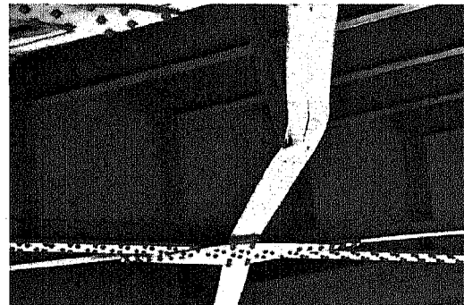
ภาพ 3.3.26: การเปลี่ยนรูปร่างสะพานกรุงธน (ตัวยึดการแกว่งของสะพาน)
