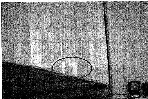
ภาพ 3.3.13: รอยแตกและหินปูนของสะพานพระปิ่นเกล้า (คานหลัก)
