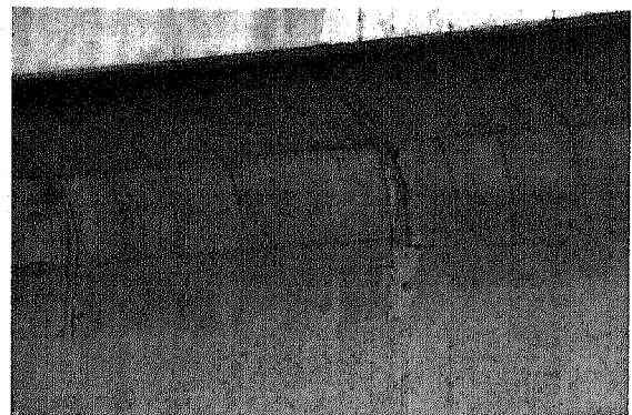
図3.3.14: Phra Pinklao橋 ひびわれ、遊離石灰 (主桁)
