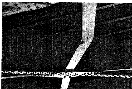
図3.3.26: Krung Thon橋変形 変形 (対傾構)
