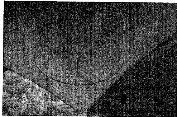
図3.3.17: Phra Pokklao橋 ひびわれ (主桁側面)
