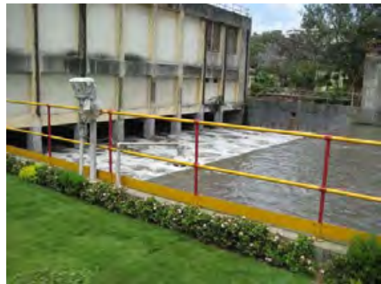
Effluent collection chamber
