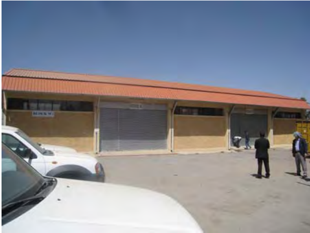
ティグライ州保健局敷地内の倉庫
