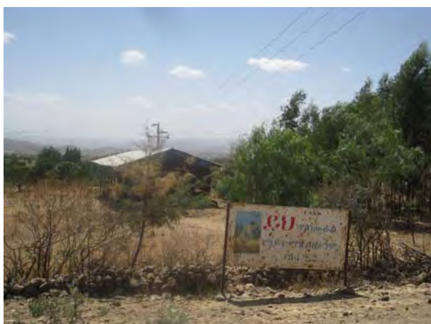
Ebinat ワレダ Zeba Mikel 保健ポスト外観。電線が上を通っているが、保健ポストに電気はひかれていない。水道もなし。
