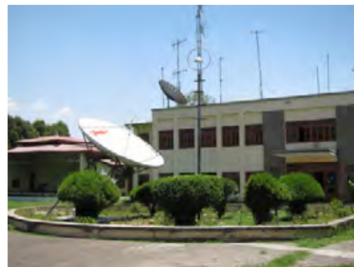
ラジオネパール送出設備
