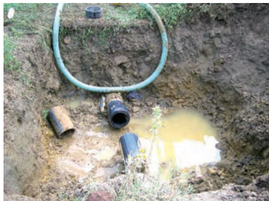
GDA が維持管理する修理中の 315mm の導水官（ネフザ地区）
