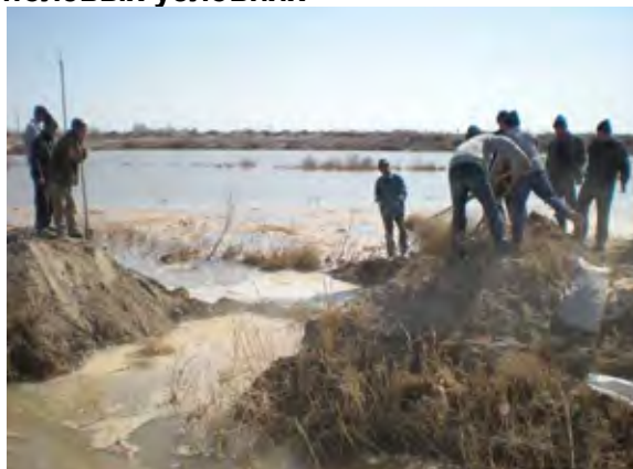
Текущий ремонт канала АВП, Март 2009
