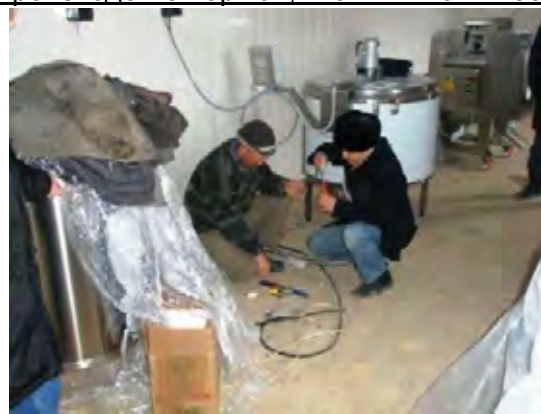
Установка оборудования по переработке молока, Февраль 2010
