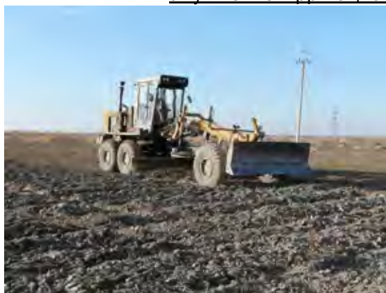
Планировка земель, выполненная местным подрядчиком
