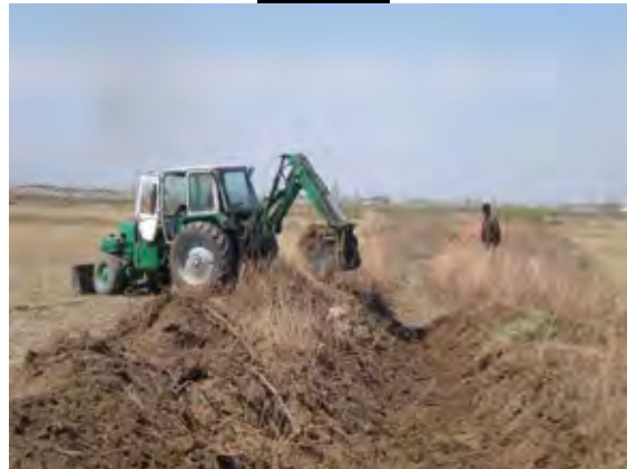
Текущий ремонт канала, выполняемый трактором АВП
