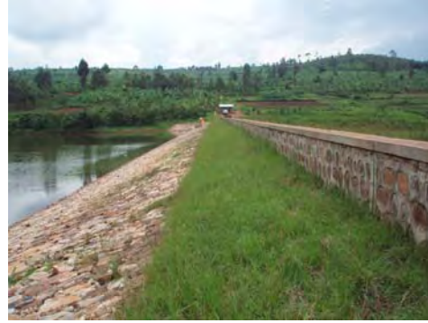
写真 6 : 堤体天端とパラペット
