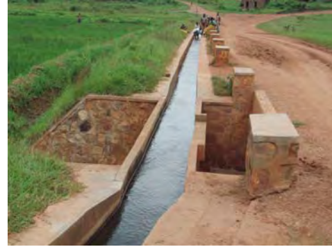
写真 10 : 右岸幹線水路
