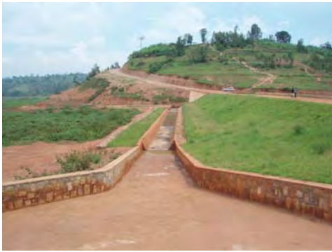
写真 2 : 洪水吐下流水路
