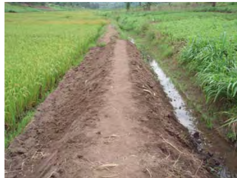
写真 2：左岸幹線水路
