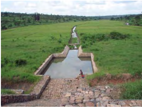
写真 11 : 放水路と主排水路
