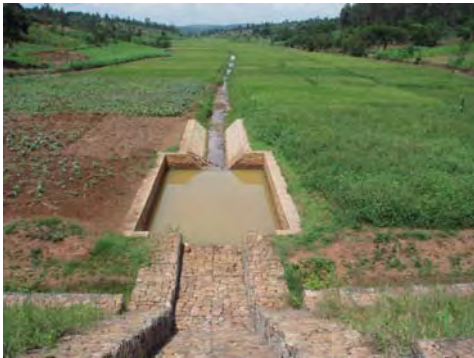
写真5：放水路と主排水路
