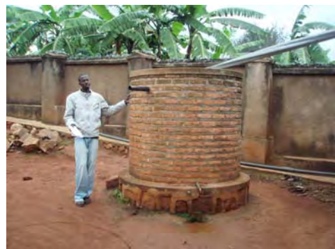
写真8：レンガ円形受水槽側面
