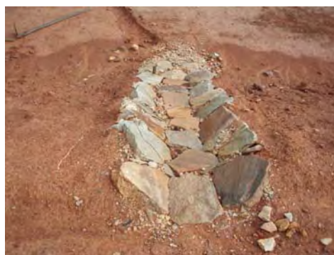
写真 22：仮設盛土侵食防止
