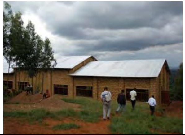
貯蔵庫建設現場の視察
