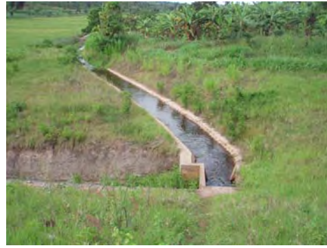
写真 12 : 右岸幹線水路
