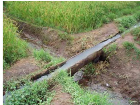
写真 10 : 湧水の排水と右岸幹線水路
