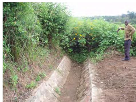
写真 6 : ため池 2 への接続水路
