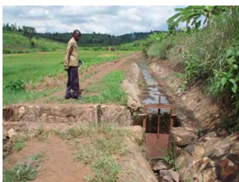
写真 5 : ため池 1 からの幹線水路
