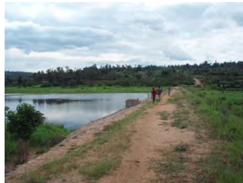
写真8：堤体（右岸より）
