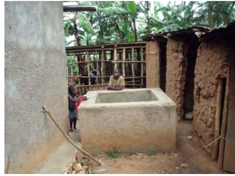
写真2：牛小屋に付設された貯水槽
