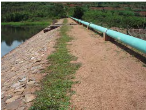
写真1：堤体（右岸より）
