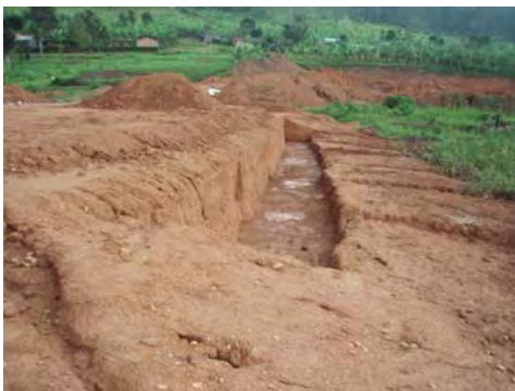
写真 11：堤体盛土（上流側）
