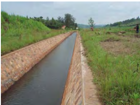
写真 9 : 左岸幹線水路
