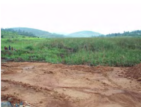
写真 13：盛土から上流
