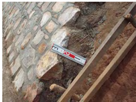
写真 5 : 建設中導水路 2 (部分)
