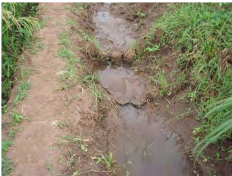
写真 3：幹線水路内の土砂受け
