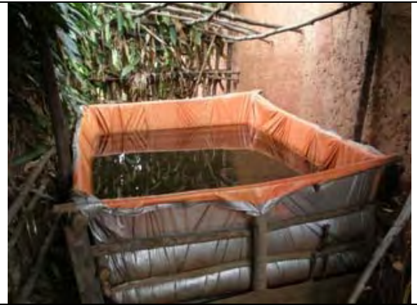
Mr. カデンデ宅の雨水貯水用のウォーター・タンク（住居の隣に設置してある）
