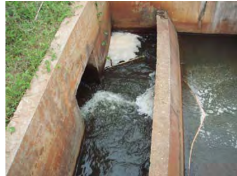
写真 8 : 幹線水路への導流部緩衝壁
