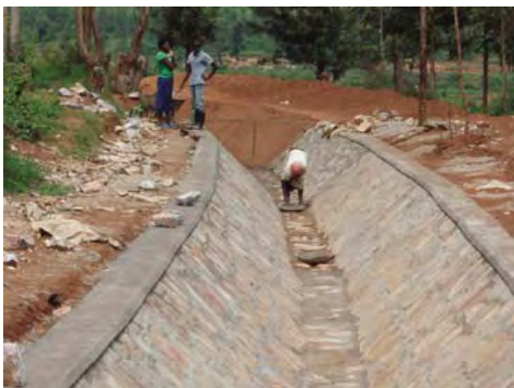
写真 4 : 建設中導水路 1
