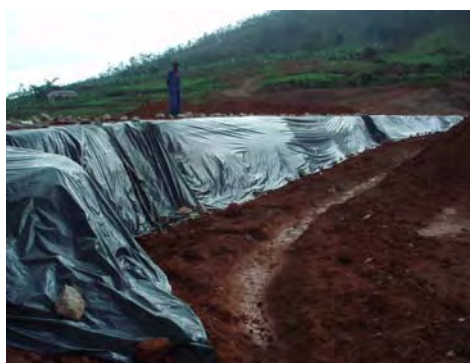
写真 18：堤体盛土状況（下流側）
