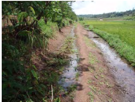
写真6：右岸幹線水路と二次水路
