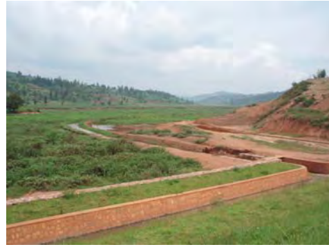
写真 3 : 堰堤下流方向
