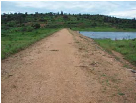
写真7：堤体（左岸より）
