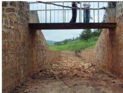
写真 4：洪水吐下流側
