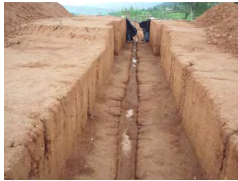
写真 14：導水路工施工前 1
