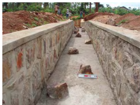
写真 7 : 急勾配水路の減勢 (自然石)
