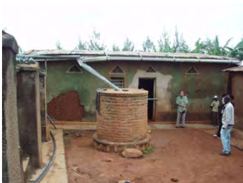
写真7：レンガ円形受水槽全体
