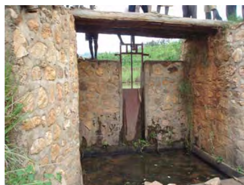
写真 4 : ため池 1 の排水ゲート下流
