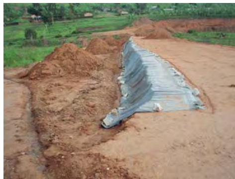
写真 12：堤体盛土（下流側）
