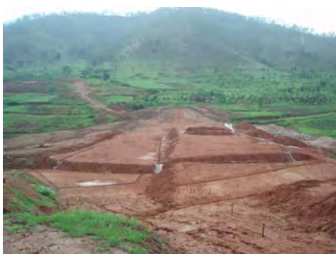
写真 17：施工現場全景（右岸より）
