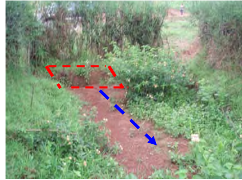
写真 2 - 33 FP1への上流側沈砂池と水路の跡
