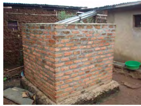
写真 2-41 方形レンガ積み受水槽
