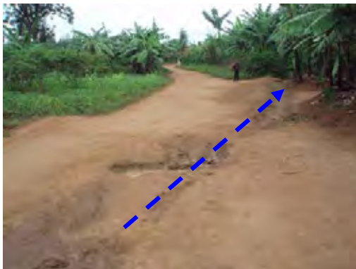
写真 2-42 道路排水利用畑灌溉 (道路を横切る水路がバナナ畑に続く)
