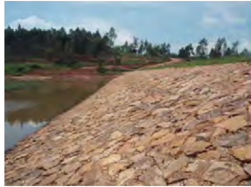
写真 2-61 ため池堤護岸
