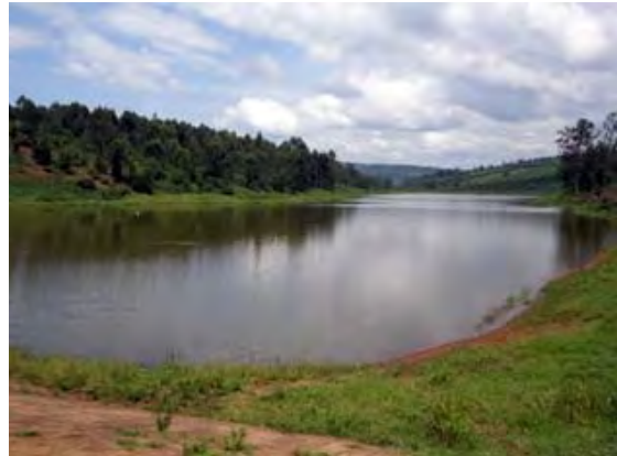
写真4 ：中国の援助によって70年代に建設されたため池。豊富な貯水量と水管理により機能している。
