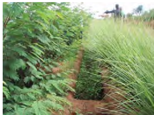
写真 2-57 土壌浸食防止工
