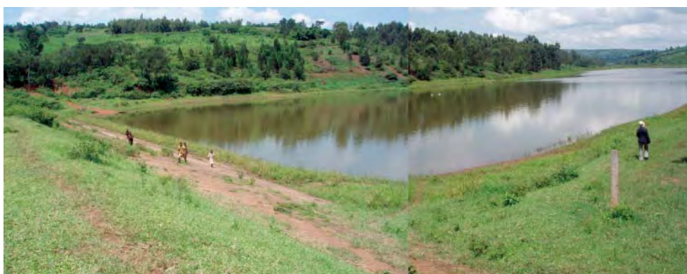
写真2－1 中国の援助によって建設されたため池
