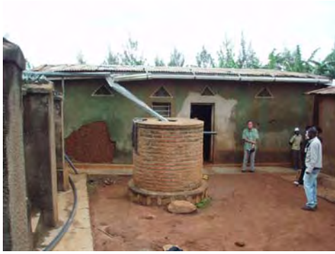
写真 2-40 円形レンガ積み受水槽
