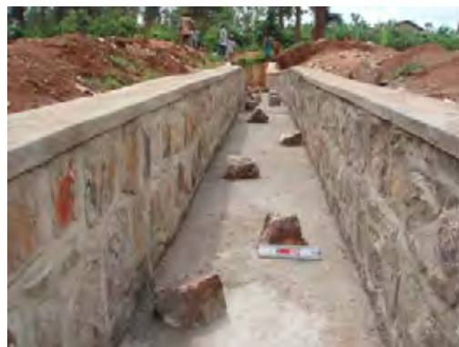
写真2-59 水路 （石積側壁と自然石による減勢工）
