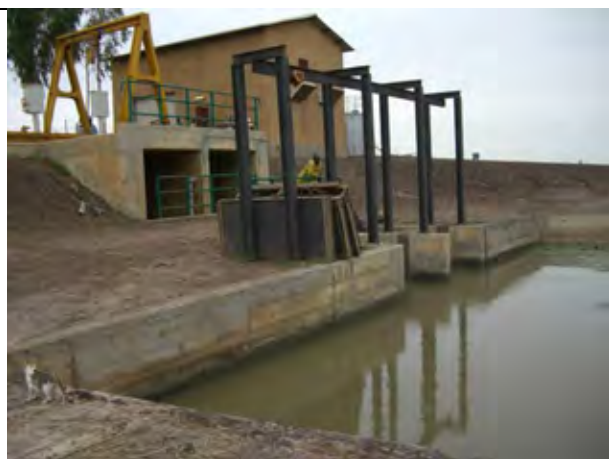
1990年代に日本の無償資金協力により改修された デビ・チゲ灌漑地区（大規模灌漑地区）の揚水機場
