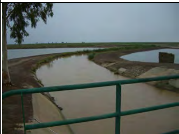
デビ・チゲ地区の幹線水路（揚水機場から望む）
