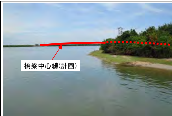
写真-1 架橋位置(東岸側より西岸を望む)
