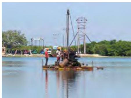
図 地質調査状況（水上部）
