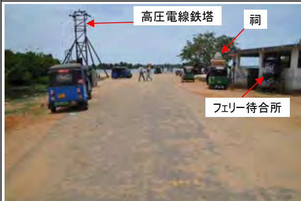
写真-3 西岸側背面側より見る 高圧電線鉄塔および祠、フェリー待合所を避けて道路を計画しており住民移転等も発生しない。
