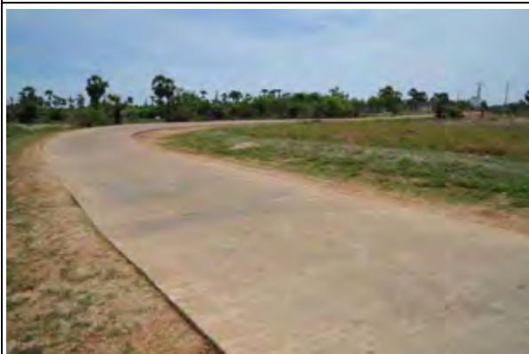
写真-5 架橋位置につながる州道(東岸側) 整備事業完了済。東岸側のフェリー乗り場付近はコンクリート舗装である。他の部分、および西岸側はDBST簡易舗装。
