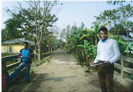
POINT (Over Culvert)
