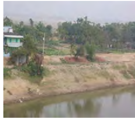
(2) クシヤラ川の河川堤防 (雨季9月撮影)
