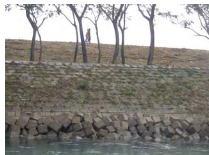
(2) カンクシャ川の堤防護岸（乾季1月撮影）
