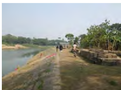
(1) ニタイ川における河岸侵食対策（護岸） （乾季1月撮影）
