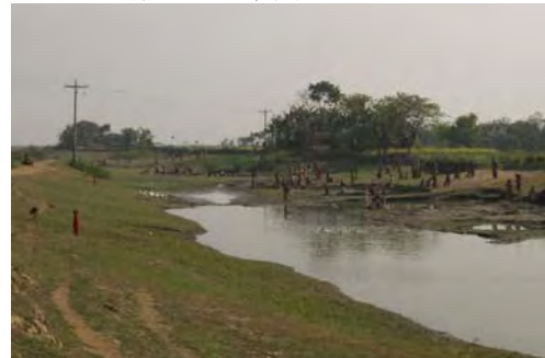
(8) 排水ゲートの出口が完全に閉塞 (乾季 1 月撮影)
