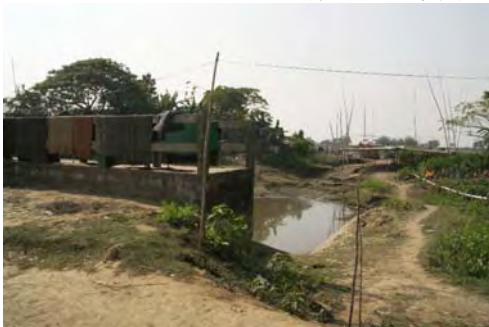
(7) 排水ゲートへの水路に土砂堆積、CNRS ( ) が集落道路の材料に利用 (雨季 1 月撮影)
