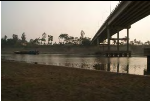
(1) シレット上流地点の河床の状況 (乾季)
