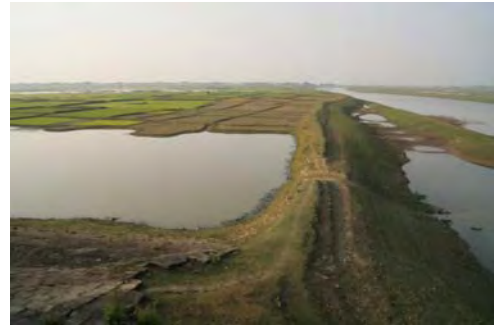
(4) モヒシン川の堤防、ボロ米のための水資源を貯留している (乾季)
