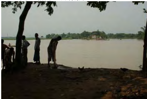
(3) ゴザリア締切堤、毎年 5 月に破堤、雨季は舟運路に（雨季 9 月撮影）
