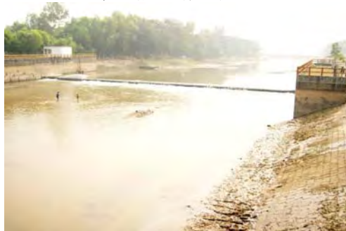
(8) ゴプラ川のカガロア堰、乾季の水位を維持 (乾季)
