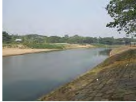
(2) ニタイ川下流、右岸部コンクリートブロック積み護岸 (2000年4月建設)
