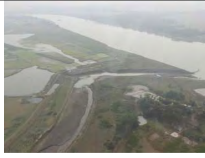
(2) ハオール排水路における土砂の堆積
