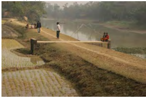
(5) ゴプラ川の堤防、排水機能を優先した設計、ボロ米用水を河川から取水 (乾季)
