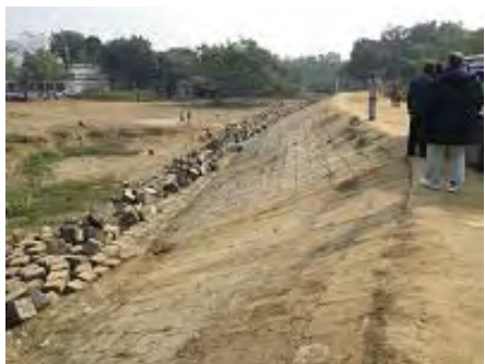
(7) ユニオンを守る堤防道路、法先に洗掘防止にコンクリートブロック積み
