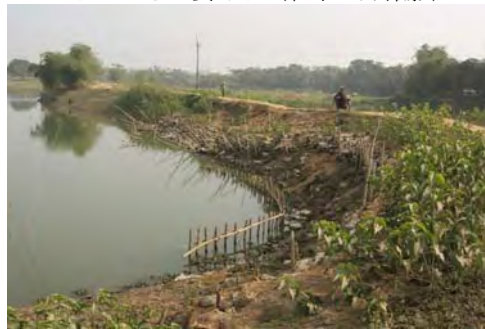
(6) 輪中堤の補強箇所、竹杭と土のうの補強で 2010 洪水では破堤せず（乾季 1 月撮影）
