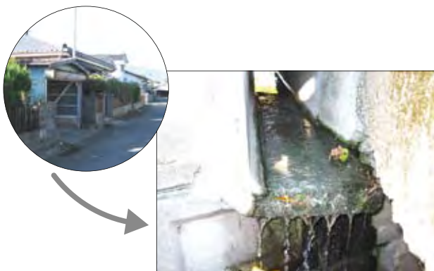
1970年代 单独式净化槽设置地区的排水沟 (沟里堆积了不少白色的污泥)
