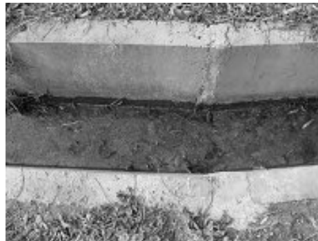
有化粪池污水排放的沟渠
