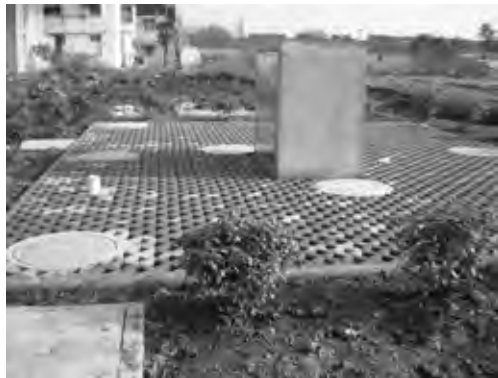
图 5-3 地理式循环间歇式生物污水处理设施
