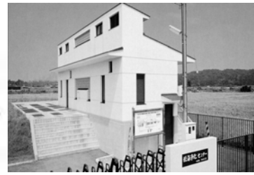
大型净化槽（RC）
