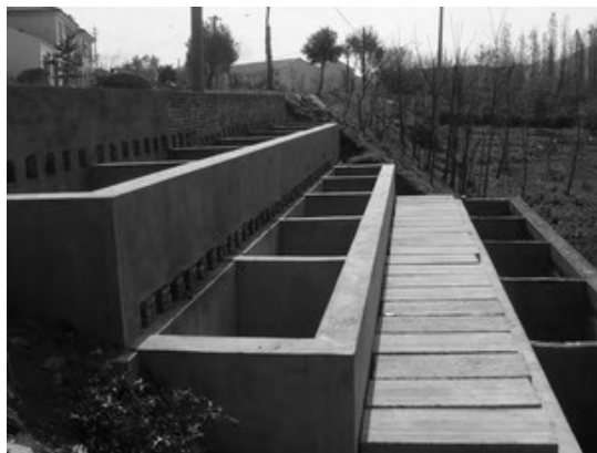
图 5-2 梯式生态滤池现场照片照片
