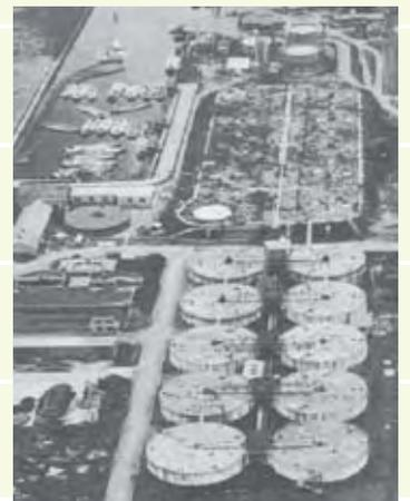
图片-1 日本战后建的大型粪便处理厂(砂町粪便处理厂,处理能力3,600 kL/日,1954年)<sup>5)</sup>
