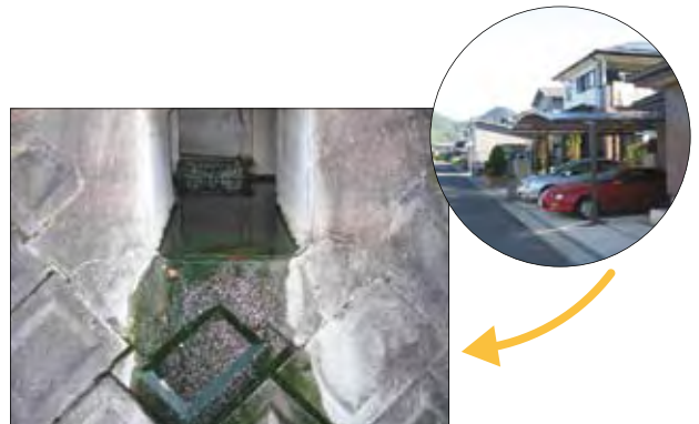
1990年代 净化槽设置地区的排水沟 (排水沟里流着透明干净的水)
