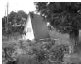
支塘鎮窯鎮村農村汚水処理ステーション
