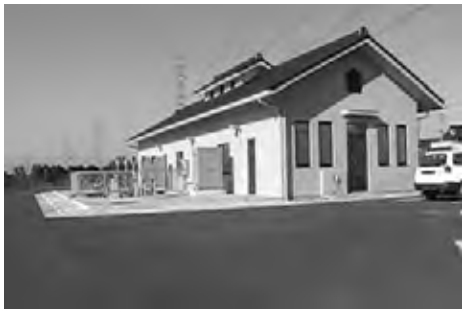
現場到着・施設外観
