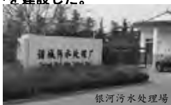
銀河汚水処理場
