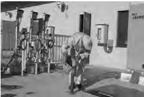
点検作業・活性汚泥槽SV測定 33
