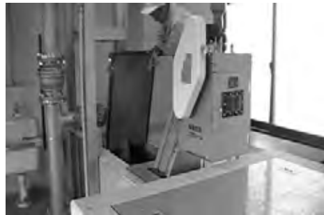
点検作業・汚水流入部 34
