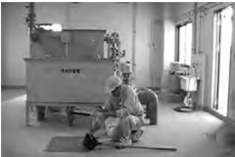
点検作業・流量調整槽pH測定 35
