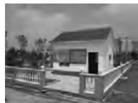
梅李鎮聚沙村農村汚水処理スポット
