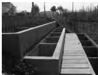
図5-2 段差式生態ろ過槽
