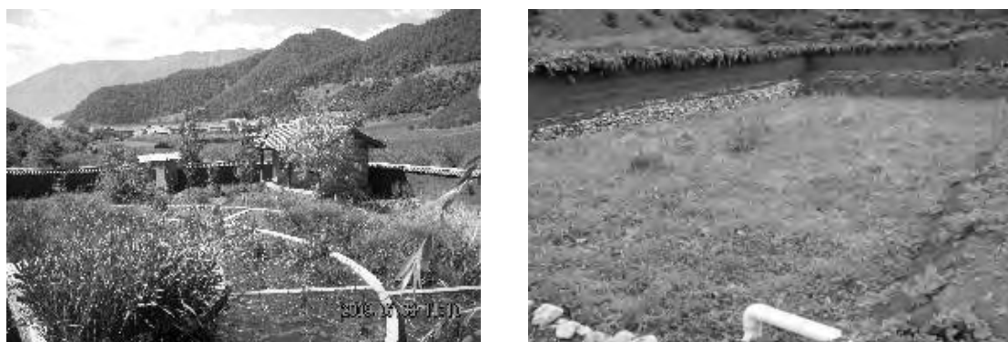
図 5-5 立体循環酸化溝（左）と亜表層浸透（右）
