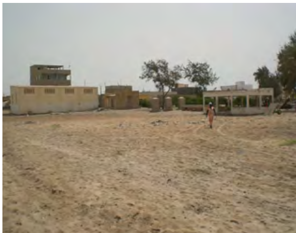
カナダ支援で建設された加工施設 左から、製品倉庫、金属製燻製釜戸、RC造燻 製釜戸、休憩施設
