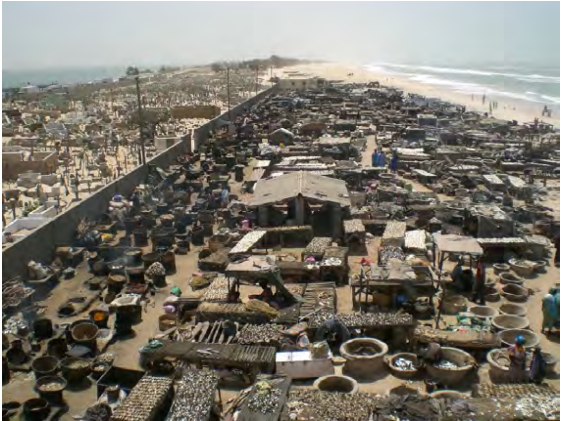
ゲンダール計画サイト（ゲンダール海側水産加工場/南側イドロバーズ方向を望む）
