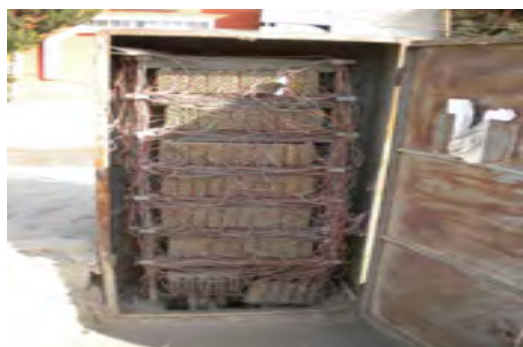
モスルの電話キャビネット 電話線の配線は不可能な状態。 ←
