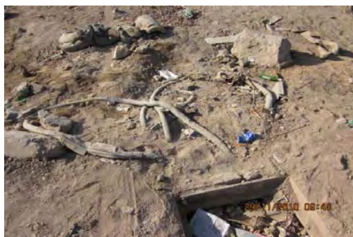
バスラの加入者線網 電話線の損傷が著しい。→
