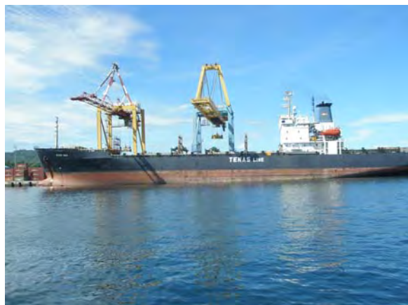
図 3.12-3 TPB コンテナ荷役の様子
