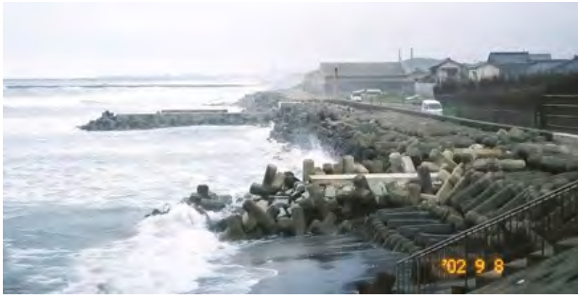
写真 7.2 神向寺海岸施工前 (2002年9月8日)
