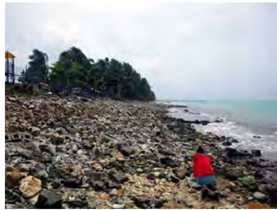
写真 5.9 Catalina Ramp の南側護岸
