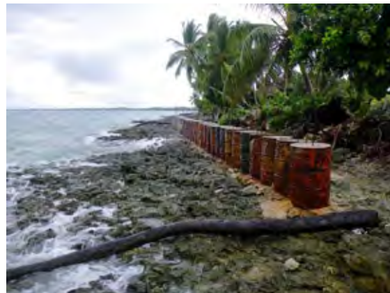
写真 5.29 個人による護岸工の例
