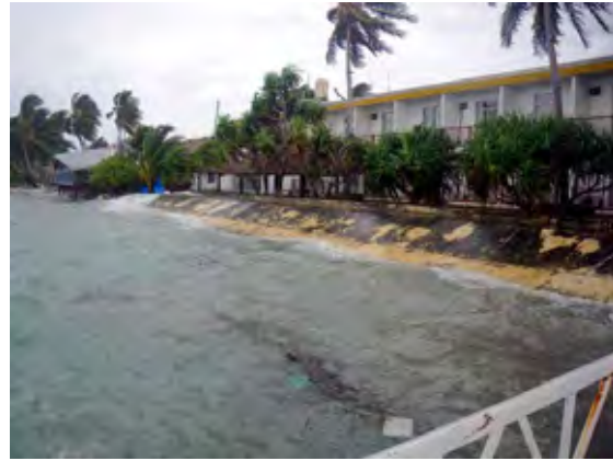
写真 5.27 直立護岸前の波浪の打ち上がり
