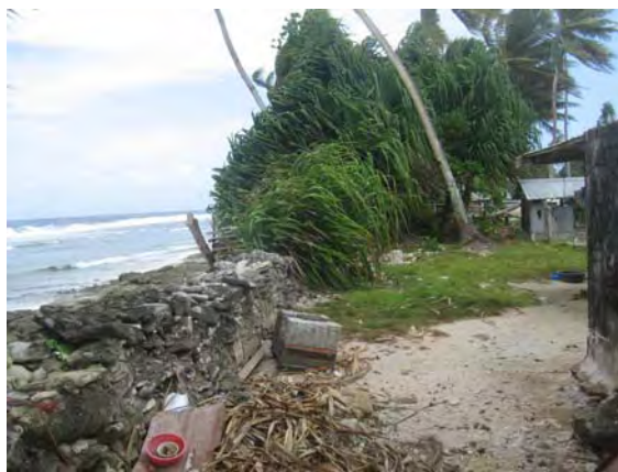
写真 5.34 個人による護岸工の例 Beach rock 片を積み上げた石積み護岸 Ocean Side No.1
