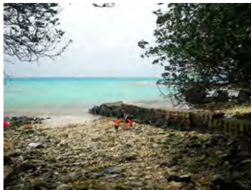
写真 5.7 小型船用突堤（Catalina Ramp（旧米軍飛行艇用斜路）南側）
