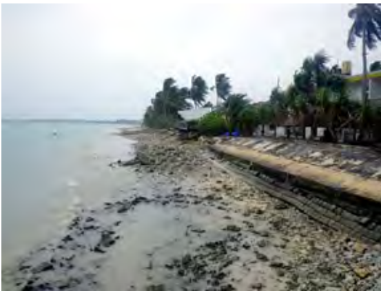
写真 5.24 公共事業による護岸工の例 Vaiaku Lagi Hotel 前の直立・傾斜の混成護岸
