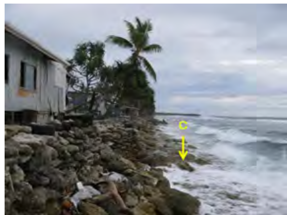
写真 5.37 個人による護岸工の例 Beach rock 片とタイヤを積み上げた護岸 Ocean Side No.2
