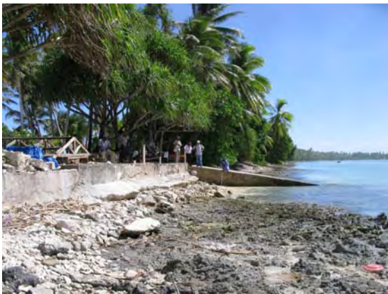
写真 5.20 Small Boat Ramp （小型船用船揚げ斜路）の北側
