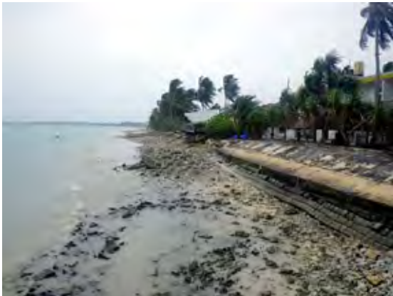
写真 5.18 小型船用ホテル栈橋の北側
