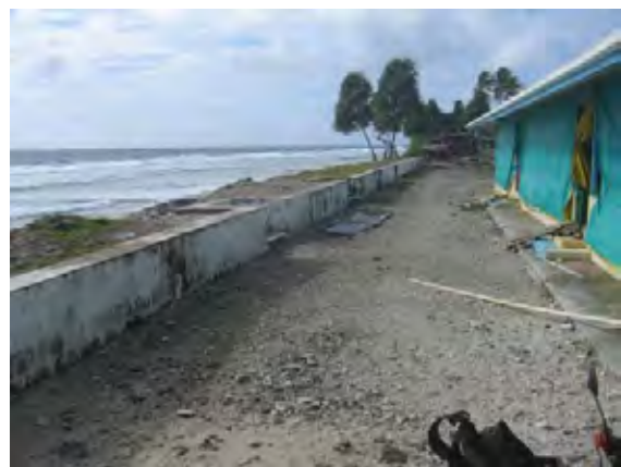
写真 5.35 教会による護岸工の例 コンクリート護岸 Ocean Side No.3
