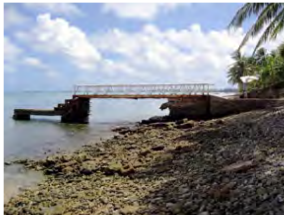
写真 5.15 Small Hotel Jetty (小型船用ホテル棧橋)
