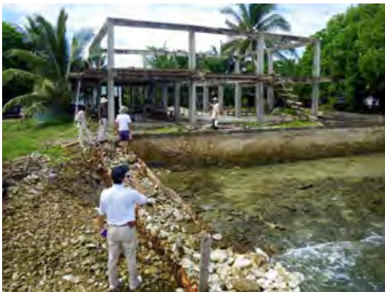
写真 5.32 個人による護岸工の例 土地の造成を目的としたもの
