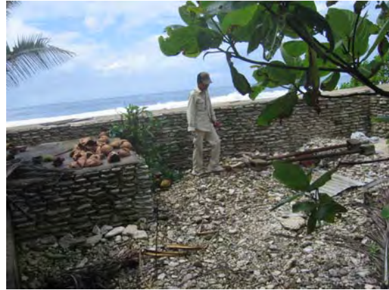
写真 5.39 個人による護岸工の例 練り石積み護岸 Ocean Side No.4
