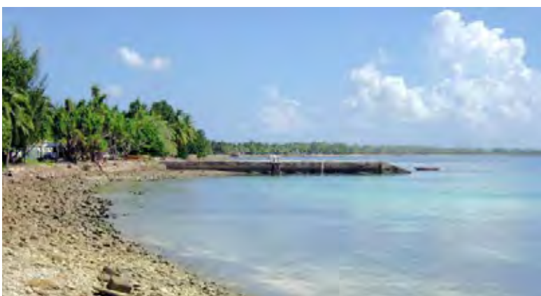
写真 5.13 Vaiaku Wharf (Vaiaku 栈橋) 南側より臨む
