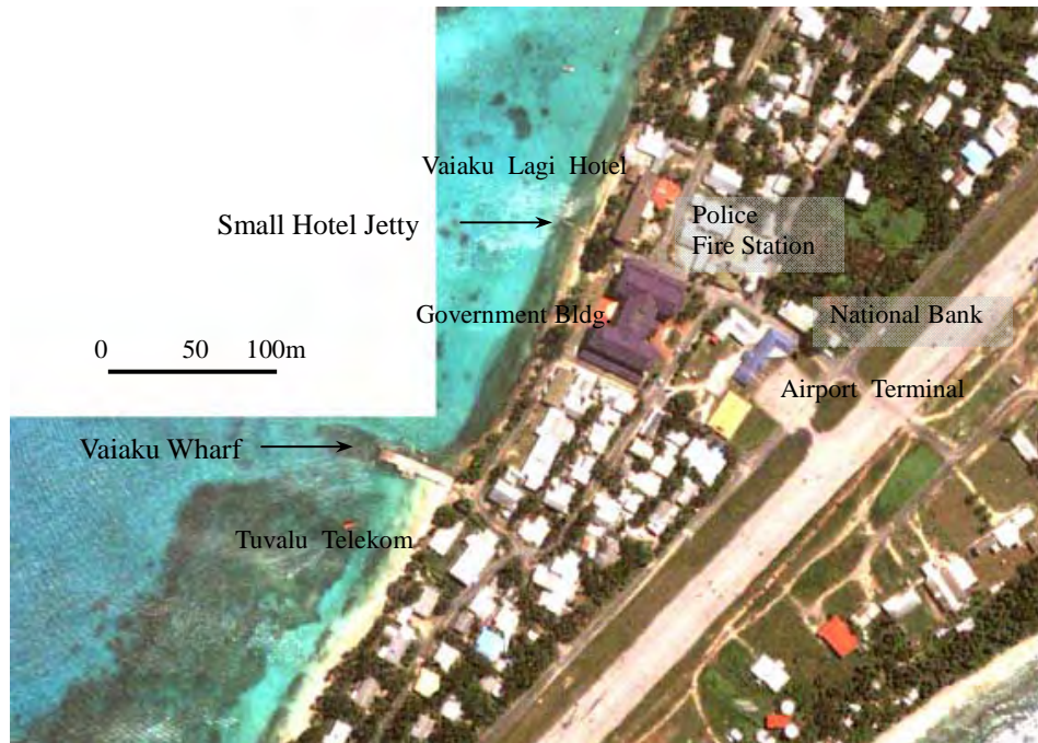
写真 5.12 Vaiaku Wharf 周辺の衛星画像
