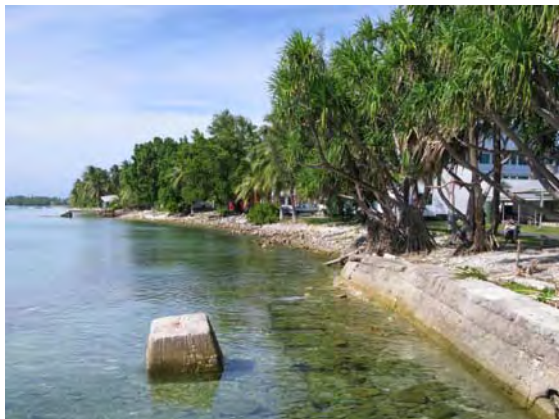
写真 5.16 Vaiaku Wharf 両脇の北側
