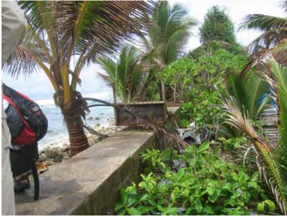
写真 5.38 個人による護岸工の例 コンクリート護岸 Ocean Side No.4
