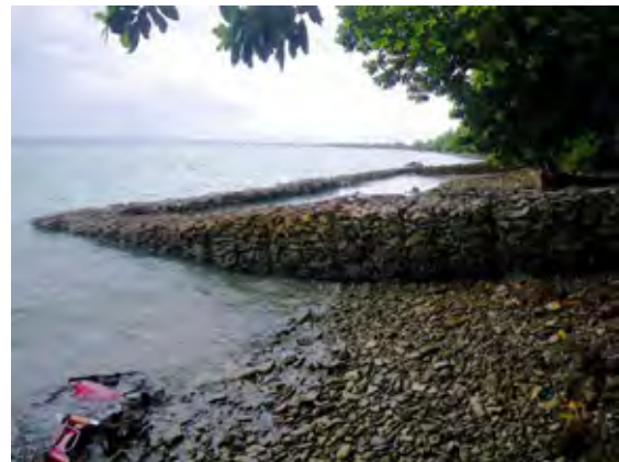
写真 5.33 個人による護岸工の例 まだ、じゃ籠工しか出来ていない状態
