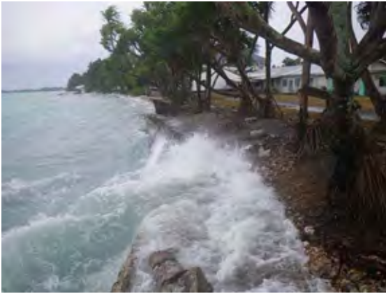
写真 5.26 直立護岸前の波浪の打ち上がり
