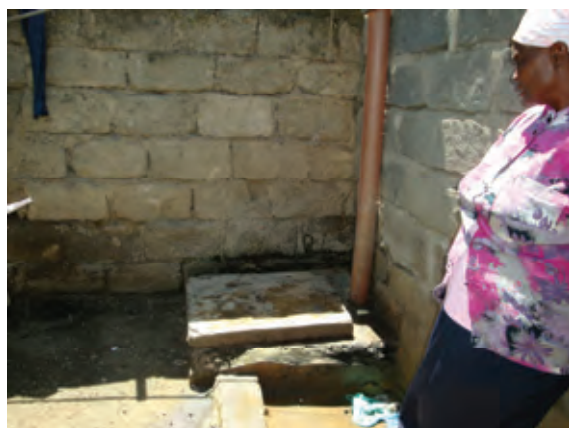
写真 3 - 4 低所得者層居住区域での污水管への接続
