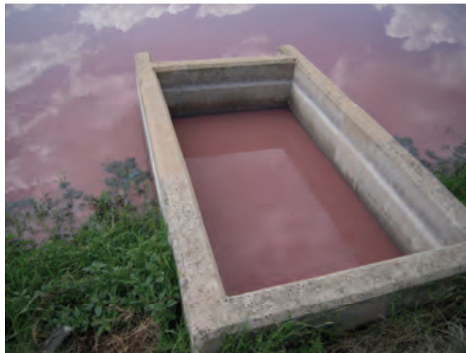
写真3-1 Njoro 下水処理場の通性池の汚水
