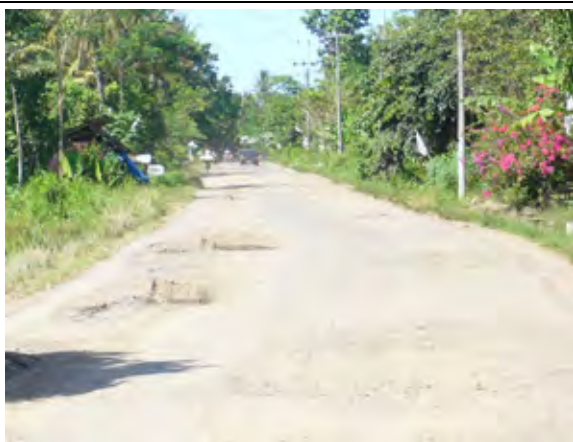
道路沿いに3相 - 3線、20kV、50Hzの送電線
