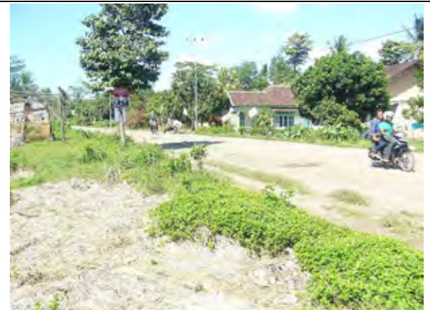
道路の幅員は7.7mあるが凸凹が多い。
