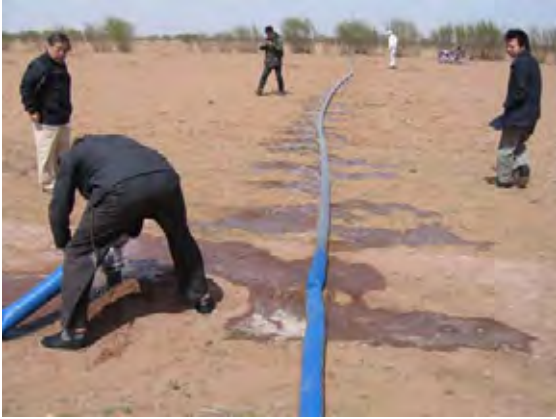
地上排水パイプの取り付け(錫尼鎮)
