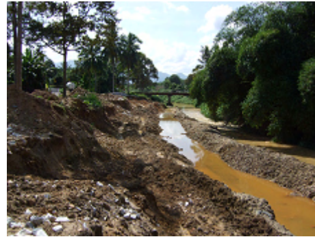
Kawasan Rumah Murah 付近の河川改修
