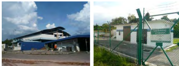
Temerlohウェットマーケット（左）とその汚水処理場（右）
