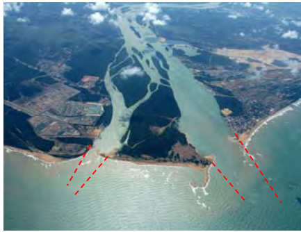
パハン河口部と防波堤の設置箇所
