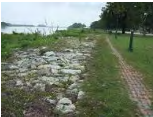
Pekan の水位観測所地点の 河岸侵食防止工
