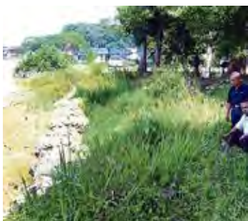
Kg. Melayu の緊急工事
