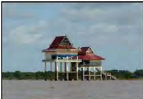
写真5：トンレサップ湖内に建設されているの既存寺院
