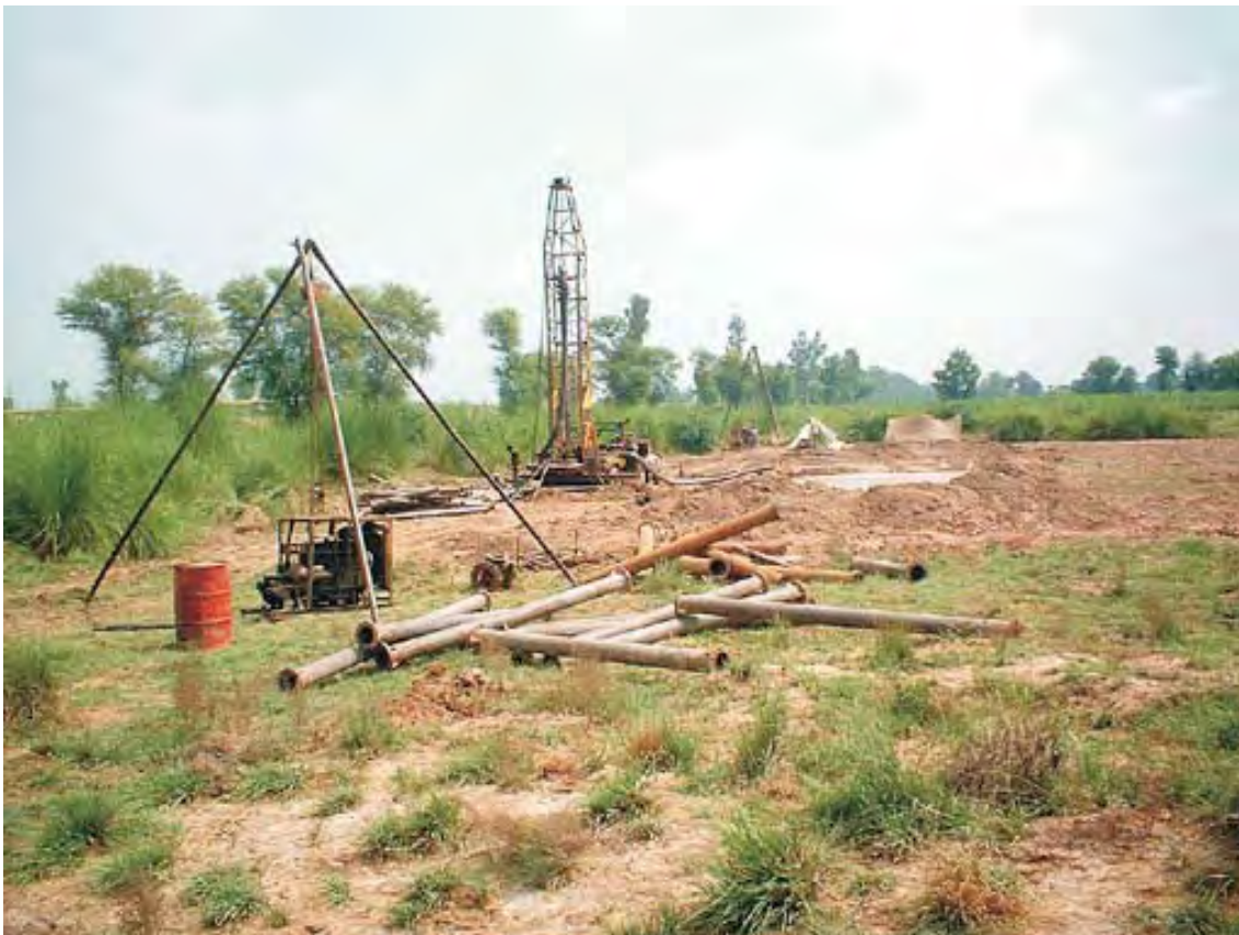
機が試験井。その後方が観測井2号。左側の黄色の掘り出し機がジャン用水路を横断するガス管橋。
