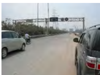
Signs on Ha Noi-Cau Gie
