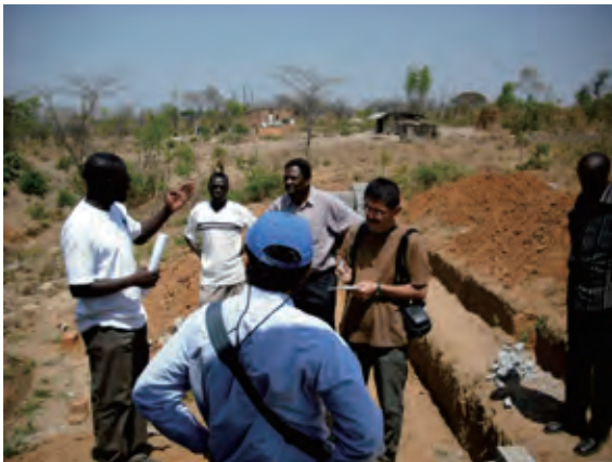
ペタウケ郡食品加工所建設現場
