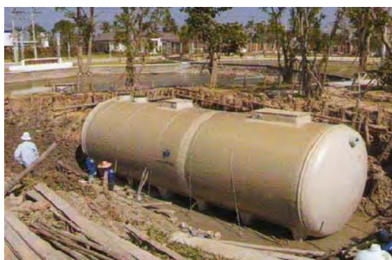
ຮູບ 5.4.1 ສິ່ງອຳນວຍຄວາມສະດວກຂອງ ການບຳບັດສິ່ງໂສ້ໂຄກ
