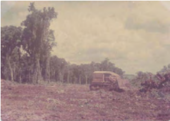
分場敷地の造成工事
