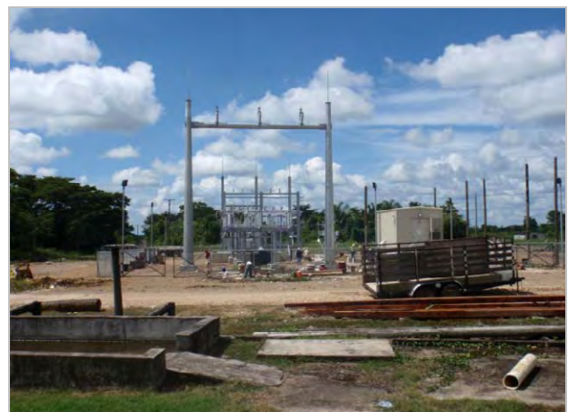
新規ベルモパン変電所(建設中)
