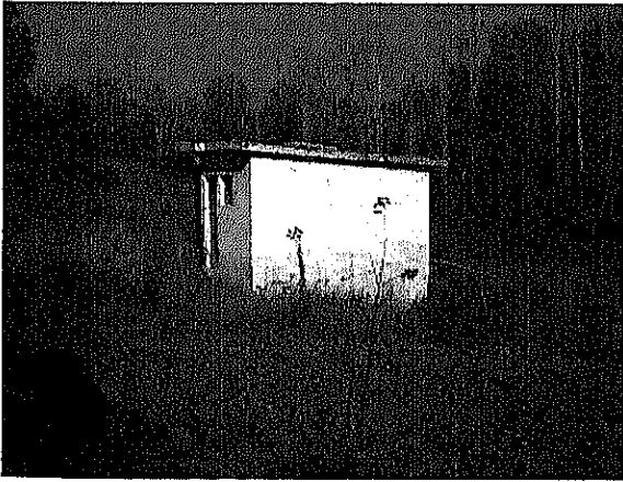
Foto 5.35 Mevcut Pompa Ekipmanları
