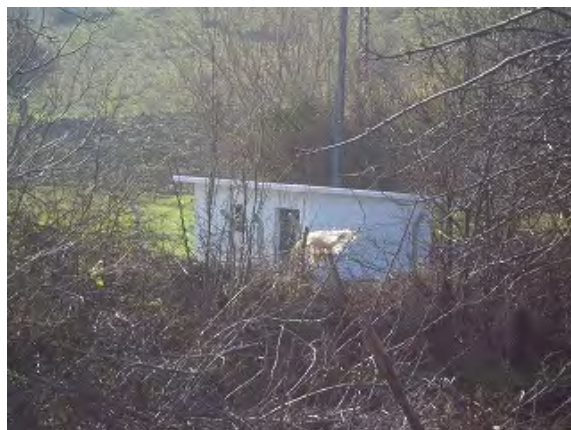
写真 5.36 新設ポンプ設備
