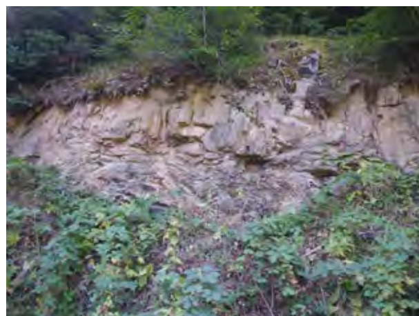
写真 5.4 ダムサイト右岸の道路法面の砂岩（上）と泥岩（下）
