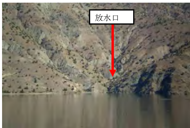
写真 5.28 Gökçekaya 湖右岸の放水口計画位置に分布する滑り岩塊
