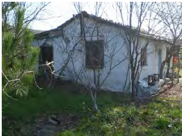
写真 5.43 要移転家屋 (常駐居住者あり)
