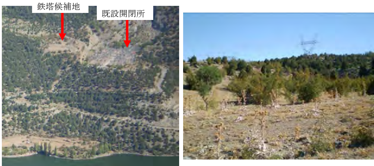
写真 5.50 既設開閉所へ繋ぎこむ送電鉄塔候補地点
