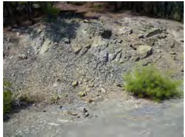
写真 5.13 スレーキングにより棒状に砕け た泥岩
