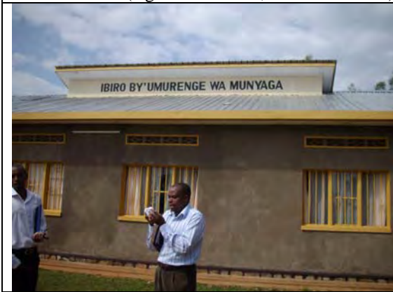
Secteur Office (Munyaga Secteur, Rwamagana District)
