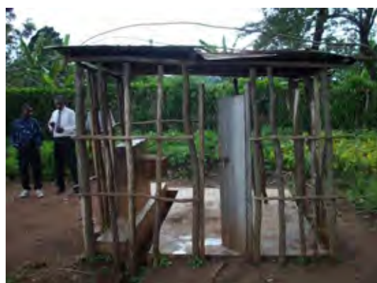
囲いが設置された公共水栓
