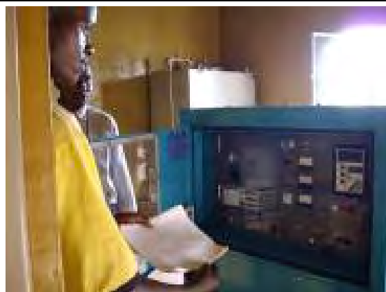
ポンプ操作人による発電機検査
