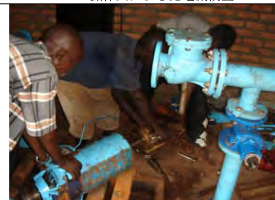
送水ポンプの修理
