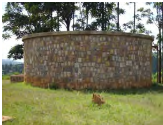
現地建設配水槽
