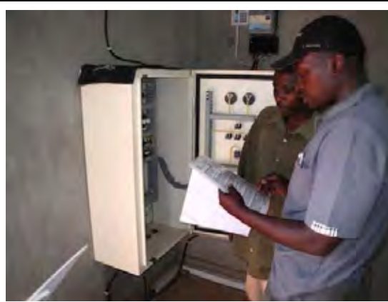
ポンプ操作人による制御盤確認
