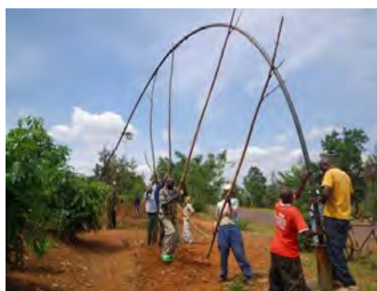
住民参加のハンドポンプ修理
