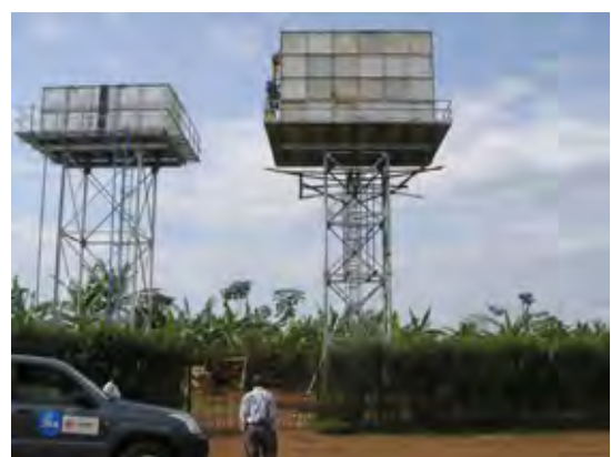
RWASCO (旧 ELECTROGAZ) の高架水槽
