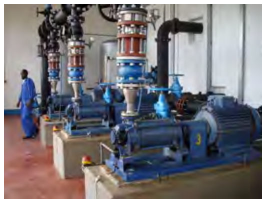
ブゲセラ郡送水ポンプ
