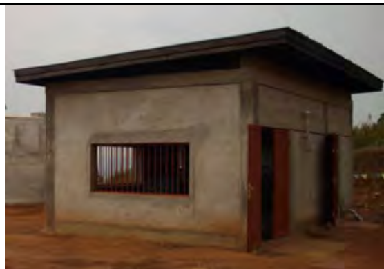
ブースター・ポンプ室
