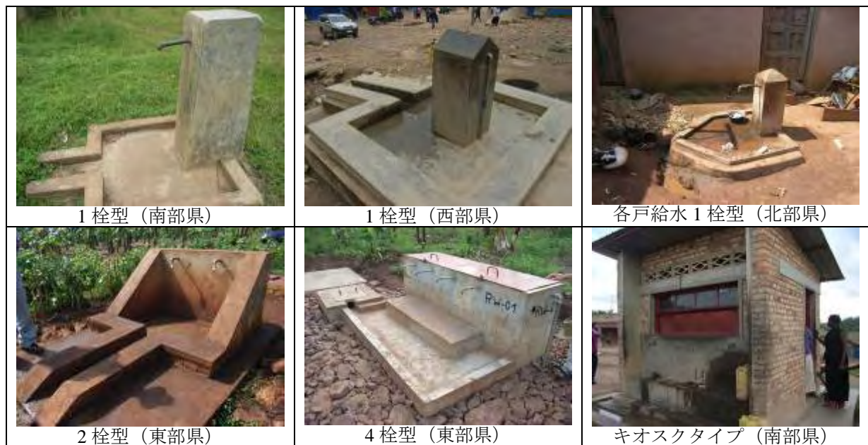
図 2-6 ルワンダ国の水栓施工例
