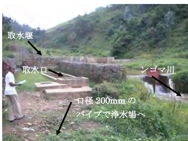
ンゴマ川トープ取水地点
