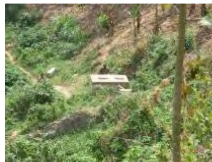
取水地点 (中央は既存取水施設)
